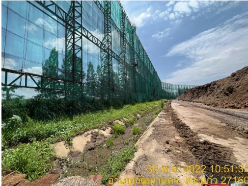
รูปที่ 10 รางระบายน้ำรอบลานกองเชื้อเพลิง
