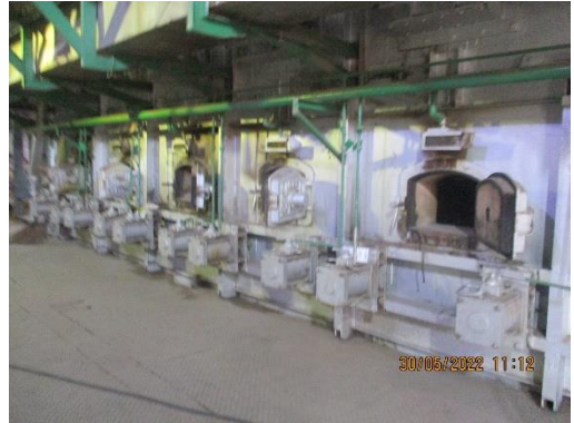
รูปที่ 11 ห้องเผาไหม้หม้อไอน้ำ
