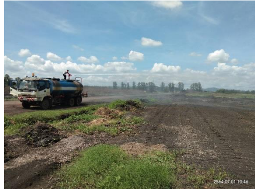
รูปที่ 15 การฉีดพรมน้ำกองเถ้าแห้ง
